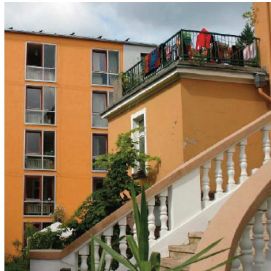
Eine Villa aus den 20er Jahren und ein fünfstöckiges Flachdachgebäude bieten viel Platz zum Wohnen und Arbeiten.
